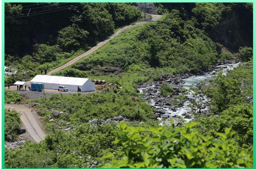
小規模水力発電施設(新潟県上越市)
